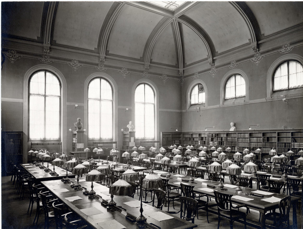
Bibliothèque publique et universitaire à Genève. La salle construite en 1905, telle qu'a dû la connaître Lénine. © Bibliothèque de Genève
